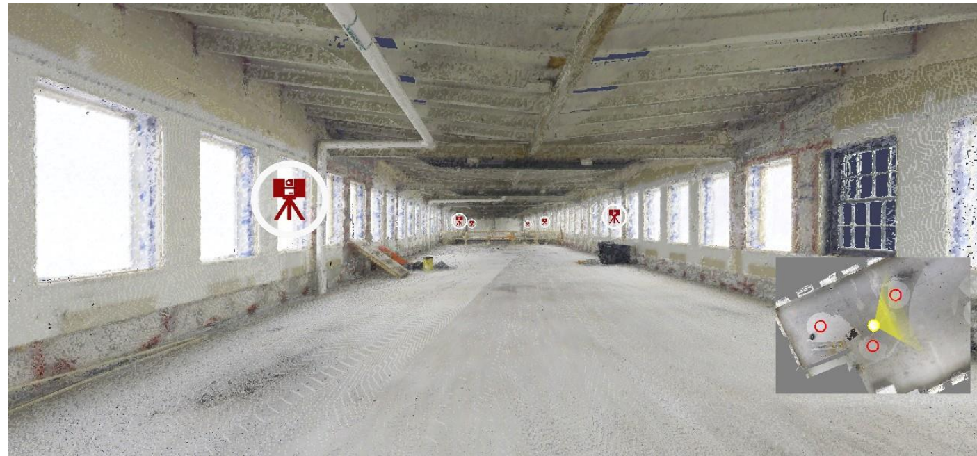
Nuage de point après démolition
