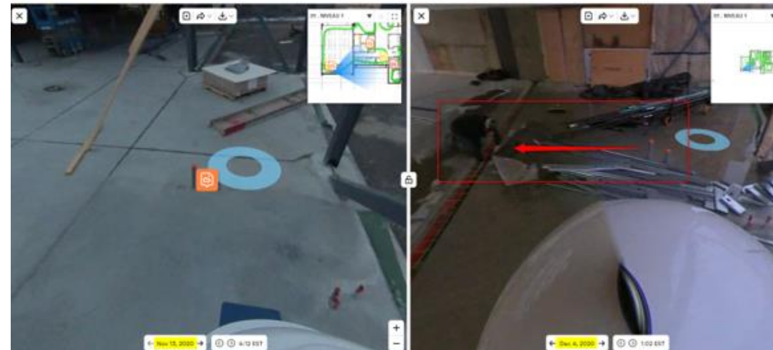
Extrait de Open Space – Contrôle de la position d'un conduit sous dalle
